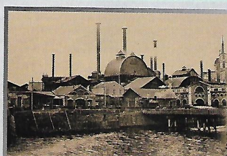
Нижнесалдинский завод на Урале
